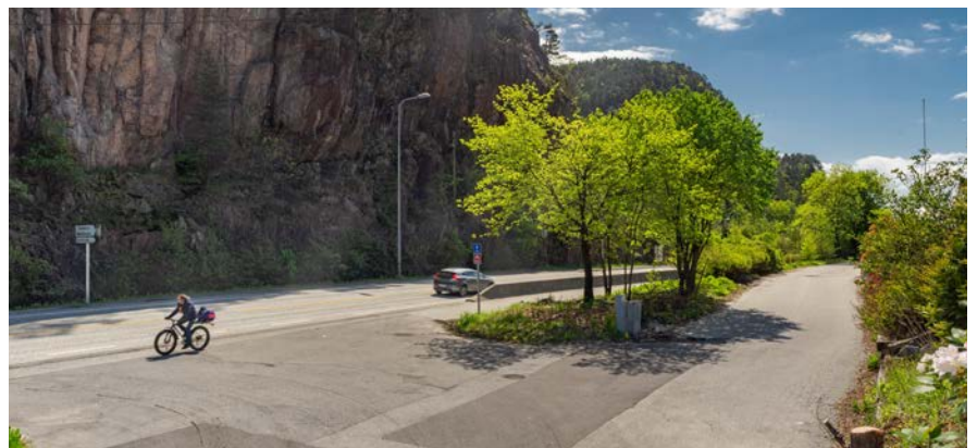
Prosjekt: Ombygging kryss avkjørsel Tennebekk næringsområde. Foto: Silje Drevdal
